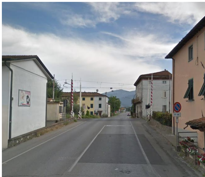
Figura 1-1 Vista del passaggio a livello esistente al km 39+728 da sostituire con il nuovo sottovia alla p. km 39+714,60
