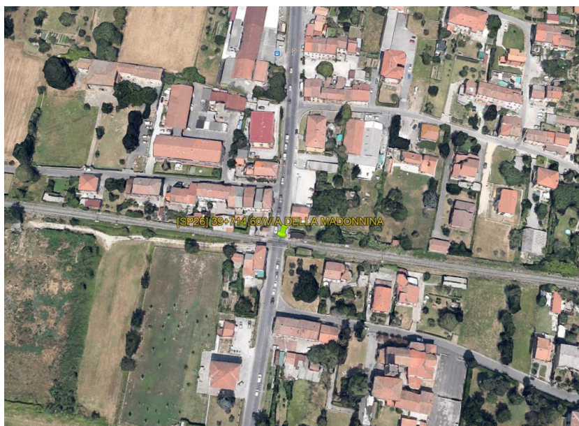
Figura 1-2 Vista satellitare del passaggio a livello esistente al km 39+728 da sostituire con il nuovo sottovia alla p. km 39+714,60
