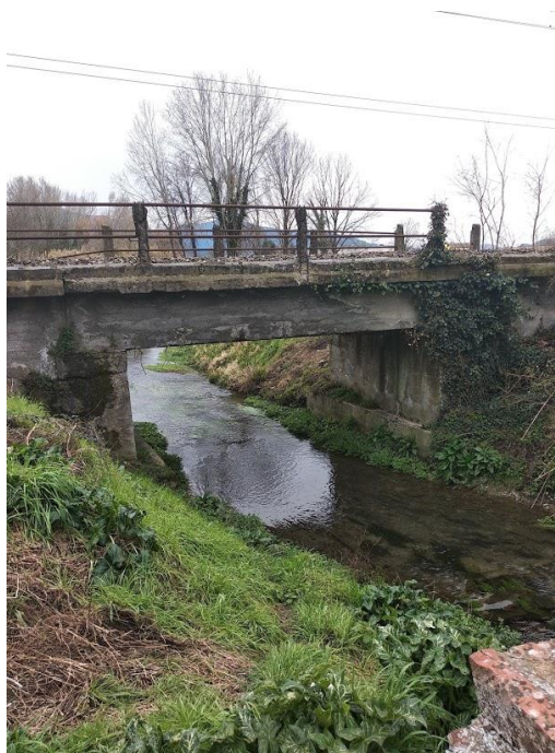
Figura 1-1 Vista del ponte esistente su canale Ozzoretto al km 41+570
